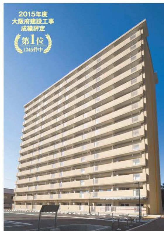
大阪府営高層住宅(大阪・東大阪市)
